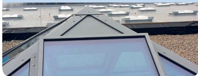
Die Pyramide hat die Maße 4,20 Meter mal 4,20 Meter, der Neigungswinkel beträgt 30 Grad.
