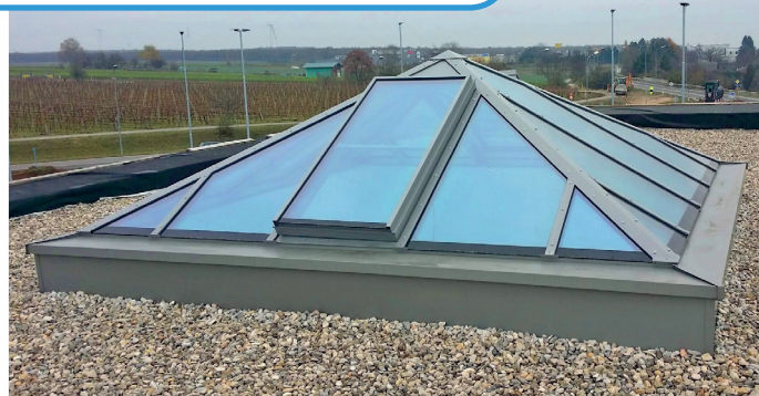
Die Pyramide hat die Maße 4,20 Meter mal 4,20 Meter, der Neigungswinkel beträgt 30 Grad.
