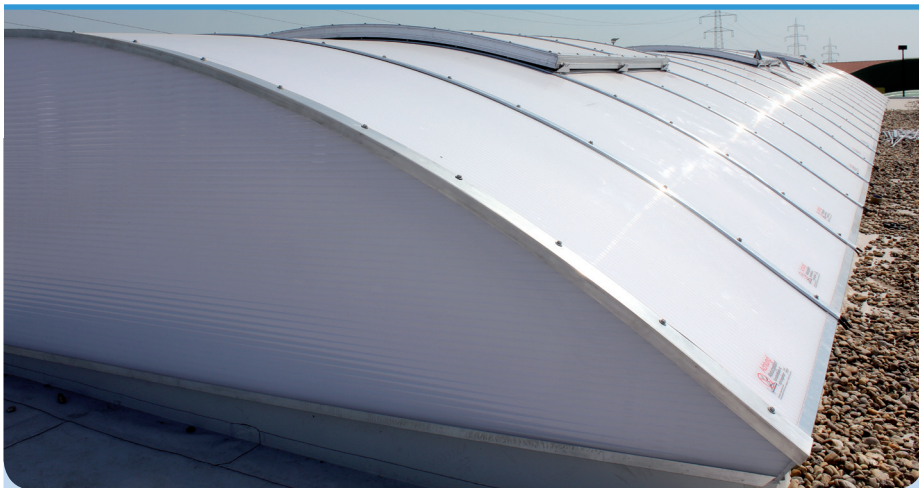
Lichtkuppeln der Serie „WEMALUX-M Thermosheet 32“ sind doppelschalig und bestehen aus Polycarbonat mit einer 32mm dicken Innenschale.
