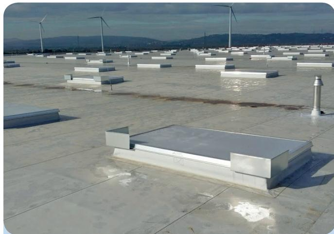
Über 150 Lichtkuppeln der Serie WEMAFLAP M montierte Eberspächer Tageslichttechnik auf diesem Hallendach.
