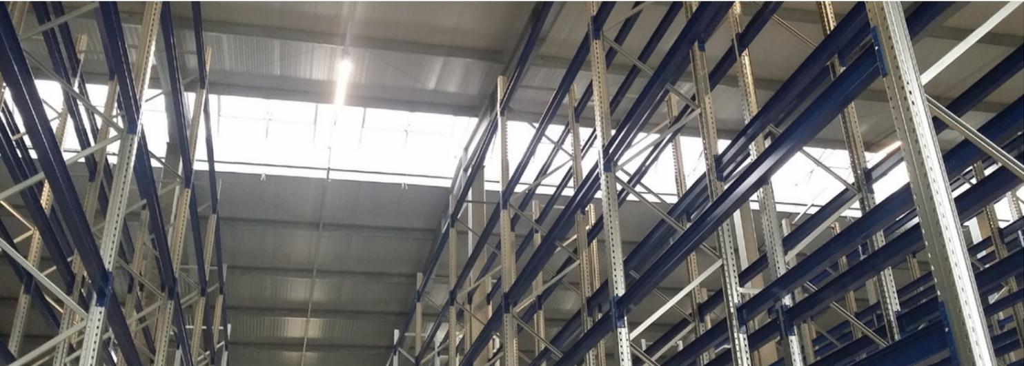
Arcolicht ist ein hochisolierendes Lichtbandsystem. Es erfüllt höchste Anforderungen, die an Lichtelemente moderner Gebäudehüllen in der Industrie gestellt werden: hervorragende Wärmedämmwerte, optimale Beleuchtung der Innenräume und Durchsturz-sicherheit nach ÖNORM B 3417. Arcolicht kann zusätzlich zur Belüftung und Brandrauchentlüftung (RWA) ausgestattet werden. Zertifiziert als Rauch- und Wärmeabzugsgerät nach ÖNORM EN 12101-2.
